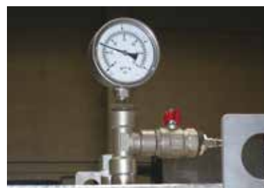
Détection de fuite
